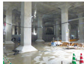
▲下高井戸調整池工事
