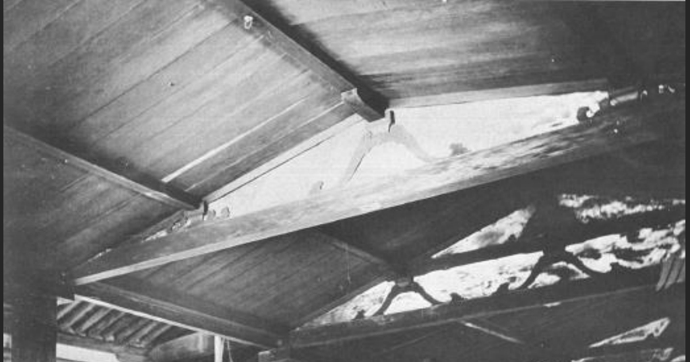
鎌倉時代に新設されていた天井の写真
