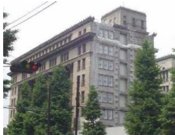
解体時東側外観
