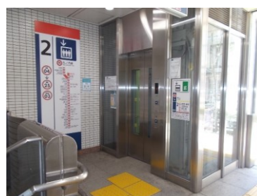
東高円寺駅 新設エレベーター
