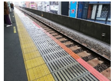
ホームの内方線付き点状ブロック
