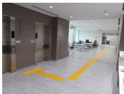
視覚障害者誘導用ブロック (阿佐谷地域区民センター)
