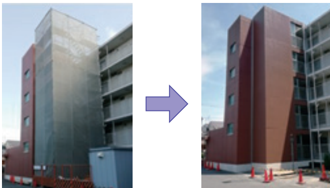
【バリアフリー改修】エレベーター設置
