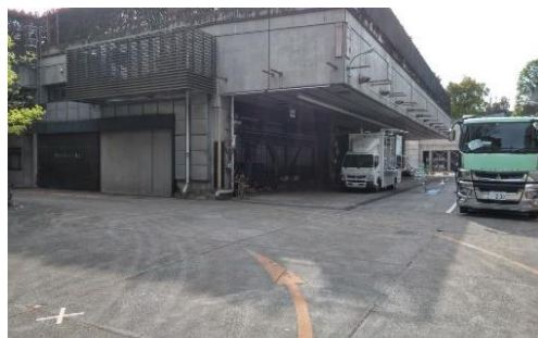
杉並中継所跡地（井草防災拠点）
