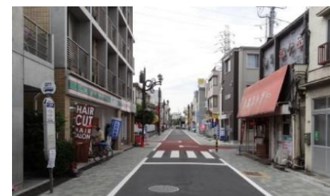
無電柱化の整備例 (特別区道第2101-1号線)
