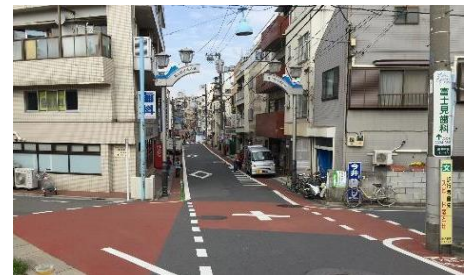
安全対策の整備例 (カラー舗装、外側線の設置)
