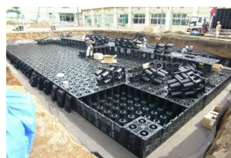
校庭下に設置する浸透・貯留槽
