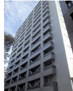
マンションの耐震改修
