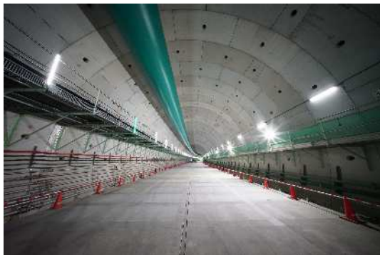
床版構築状況 (令和5年11月21日)
