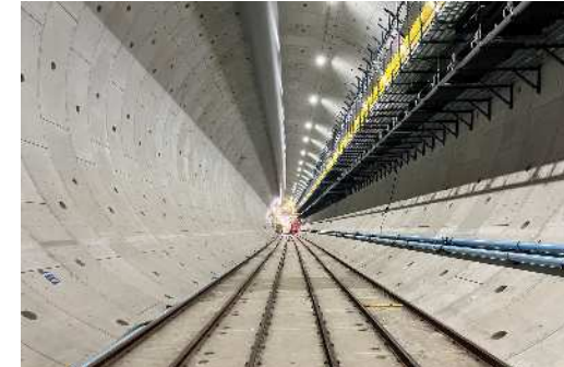
構築されたトンネル内(RCセグメント) (令和7年7月25日)
