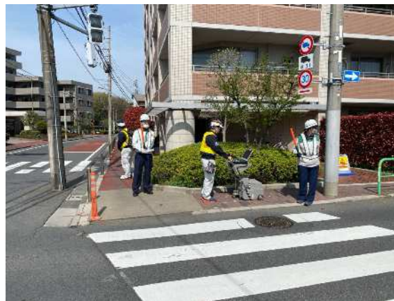
路面下空洞調査(歩道部)
