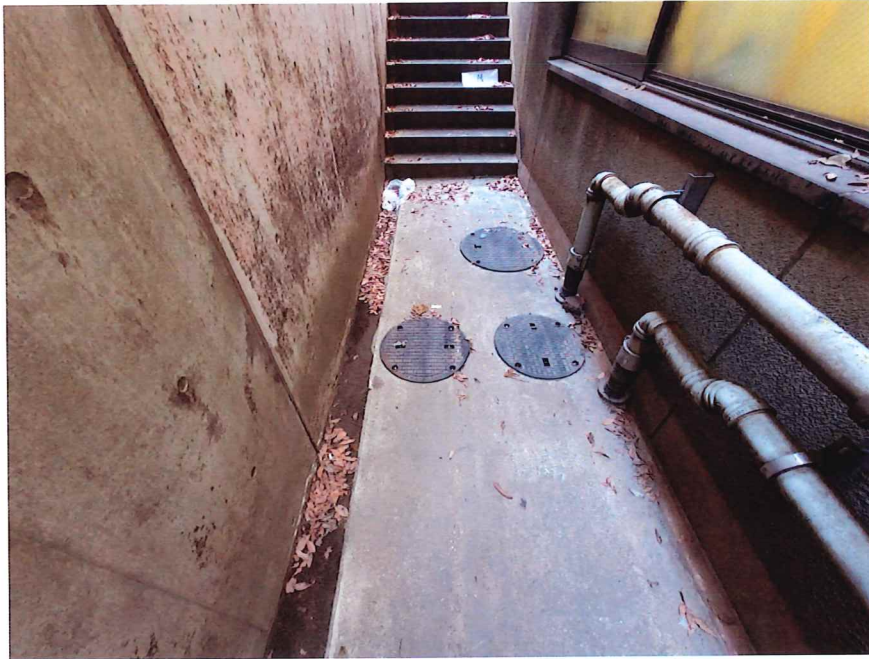
③汚水排水槽
