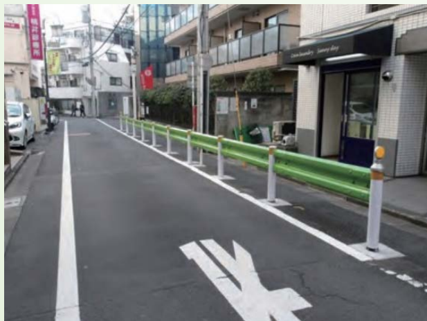
防護柵の設置
